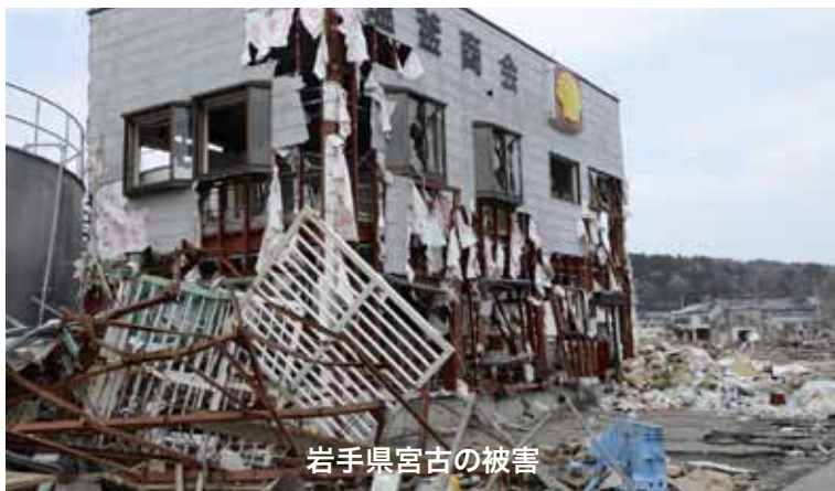
岩手県宮古の被害
