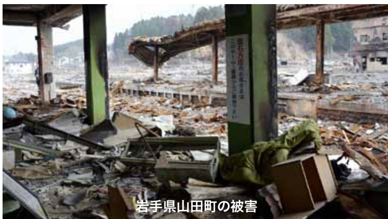
岩手県宮古の被害
